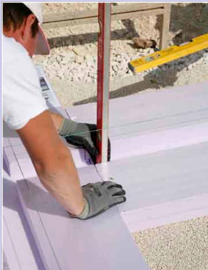
Die Ausrichtung des Systems erfolgt an einem Schnurgerüst.
