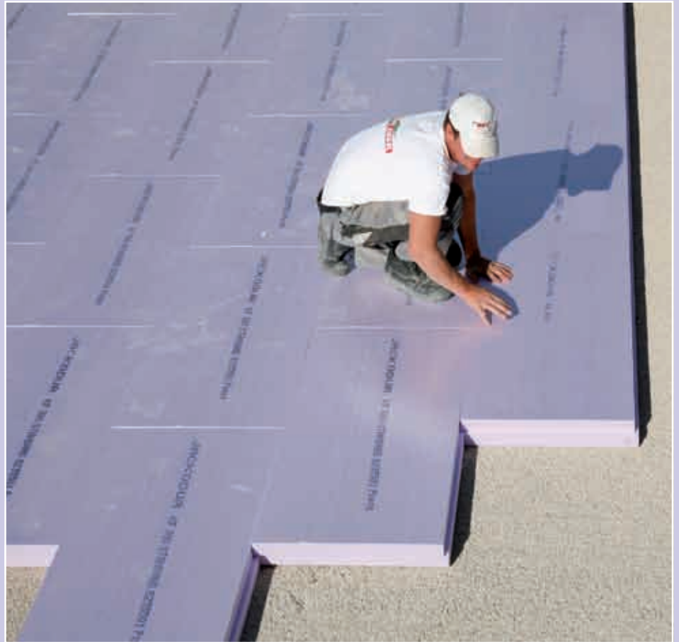
Um Kreuzfugen zu vermeiden, erfolgt die Verlegung der JACKODUR Flächenelemente im Verband.
