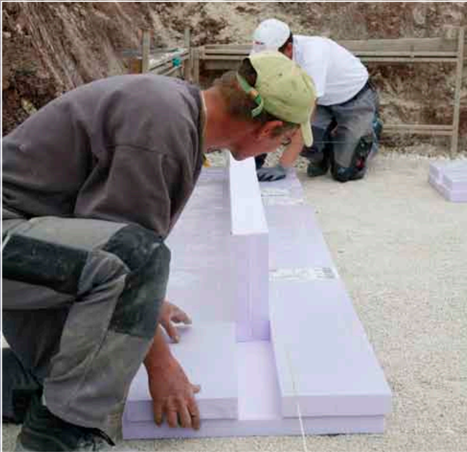
Die Schalungselemente werden einfach in die Seitenelemente eingesteckt. Die Stufenfalze gewährleisten die Wärmebrückenfreiheit.
