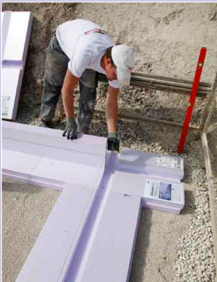
Gestartet wird die Verlegung mit einem Eckelement, anschließend werden die Seitenelemente angelegt.
