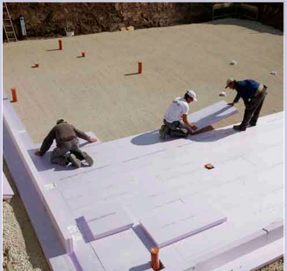
Innerhalb kürzester Zeit steht das Grundgerüst und die Flächenelemente können verlegt werden.
